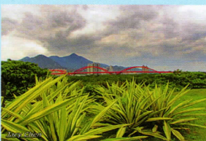
Guandu Bridge 關渡大橋
