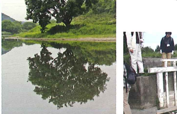
中井堰の水門
