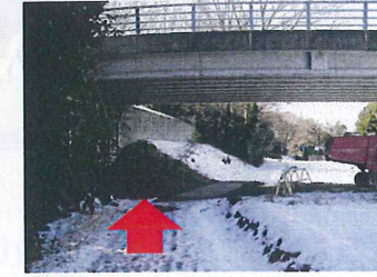
道なりに陸橋下を直進
